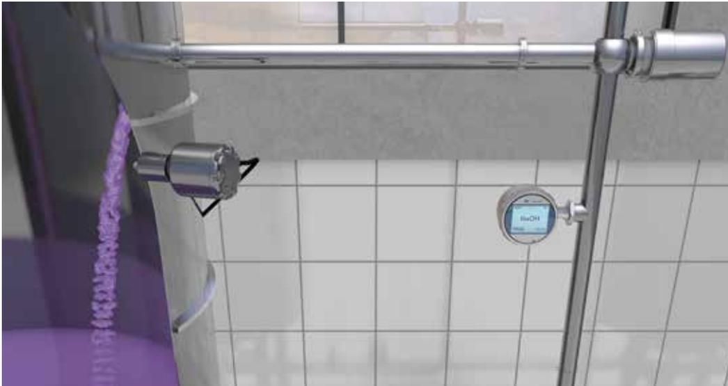
Zur Kontrolle auf korrekte Dosierung von Säure oder Lauge misst das **CombiLyz** Leitfähigkeitsmessgerät die spezifizierete Konzentration. Präzise Messwerte garantieren Lebensmittelsicherheit und die Einsparung von Reinigungsmitteln. Das robuste Sensorelement in hygienischer Ausführung stellt eine lange Lebensdauer sicher.
