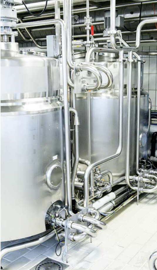
在生产优化过程中，Froneri 以堡盟传感器替代浮球开关，实现对搅拌罐的点物位检测。
